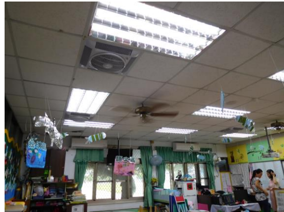
透過散熱排風扇，透過對流降低高溫
