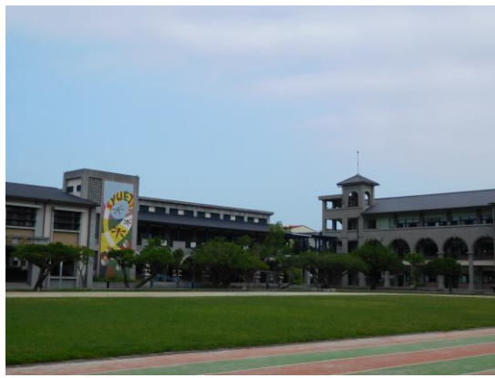
教室斜屋頂提供良好的遮蔭
